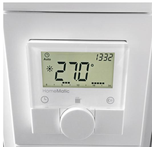
Bild 7: Zentrale Steuerungseinheit – der HomeMatic-Wandthermostat
