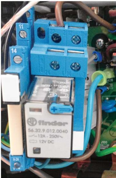
Bild 3: Steckbrücke und nachgerüstetes Finder-Relais für die Heizung
